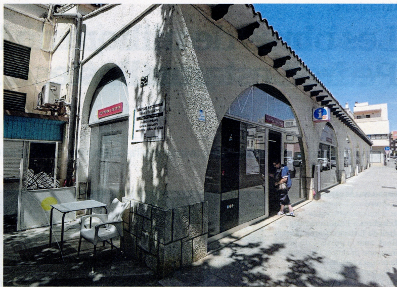
L'Oficina del Pla de Barris s'ubicarà en un espai exterior del Mercat Municipal. FOTO: JOAN REVILLAS
