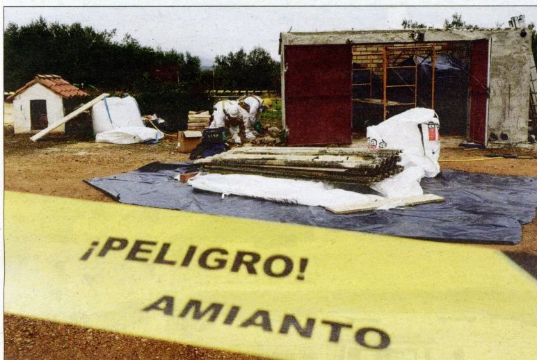
Treballs de retirada de teulades d'amiant realitzats per una empresa especialitzada. /CEDIDA
