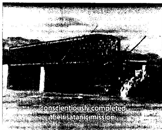
Imatge del pont del ferrocarril de Tortosa, destruït per les forces republicanes el 19 d'abril de 1938. FOTO: HQ-DO
