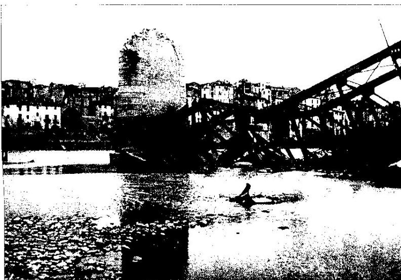
Imatge de l'antic pont de ferro de Móra d'Ebre, destruït el 4 d'abril de 1938. FOTO: BIBLIOTECA NACIONAL
