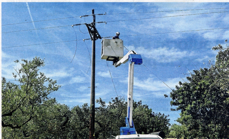
Un operari treballant en la línia elèctrica, a Mas de Barberans. FOTO: ENDESA
