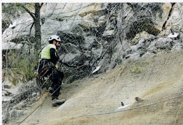
Operaris treballant en la instal·lació de sistemes de protecció com xarxes, fa uns dies a Prat de Comte. FOTO: JOAN REVILLAS
