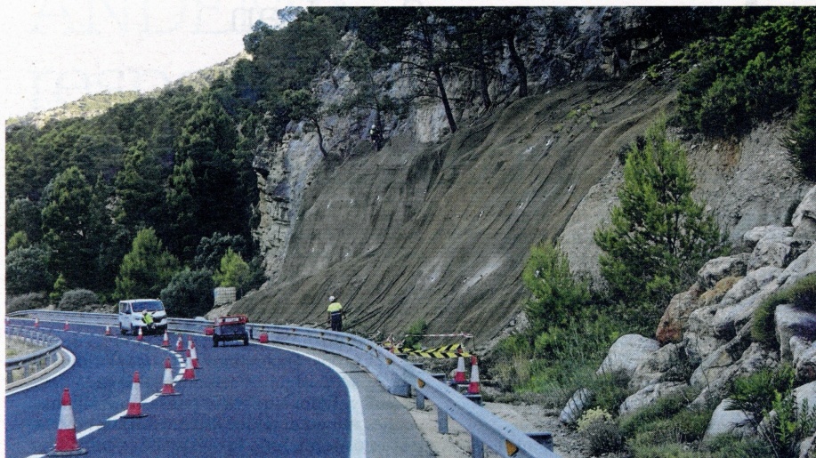
L'execució dels treballs a la T-333 obliga a aplicar passos alternatius de trànsit. FOTO: JOAN REVILLAS
