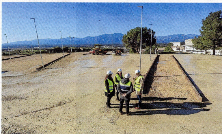
Les obres per fer l'aparcament al solar vora el fortí d'Orleans avancen a bon ritme. FOTO: J. REVILLAS
