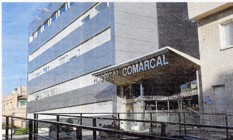
L'actual hospital, situat davant el Parc Municipal d'Amposta. FOTO: JOAN REVILLAS
