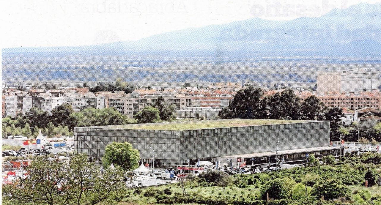
El pavelló firal de Tortosa, al barri de Remolins. SOTO: JOAN REVILLAS
