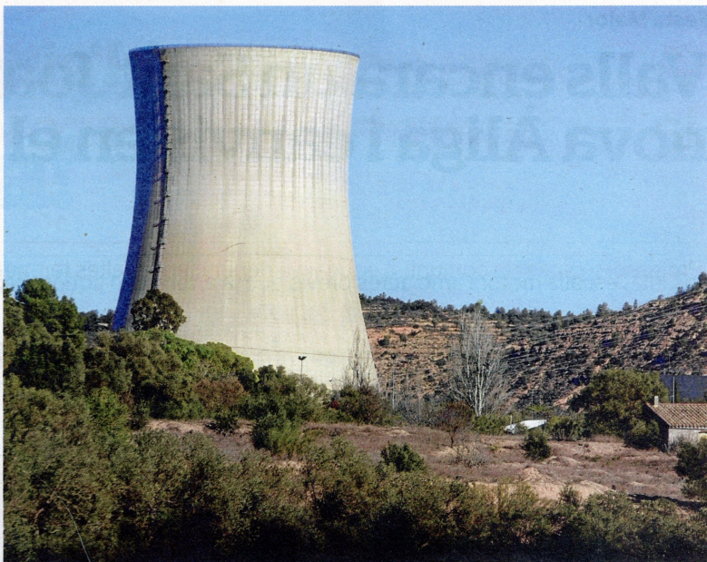
La torre de refrigeració de la central nuclear d'Ascó, a la Ribera d'Ebre. FOTO: JOAN REVILLAS
