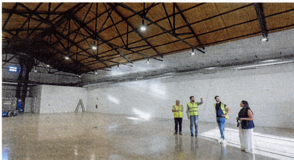
Interior de l'antiga Cambra Arrossera, en la recta final de les obres. FOTO: JOAN REVILLAS
