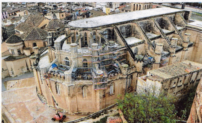
Bastides amb operaris restaurant la coberta de l'Absis de la Catedral. FOTO: J. REVILLAS
