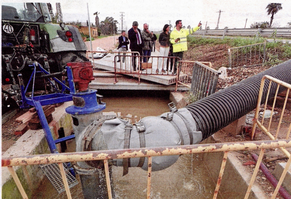
Visita a los trabajos de bombeo en Deltebre. FOTO: JOAN REVILLAS
