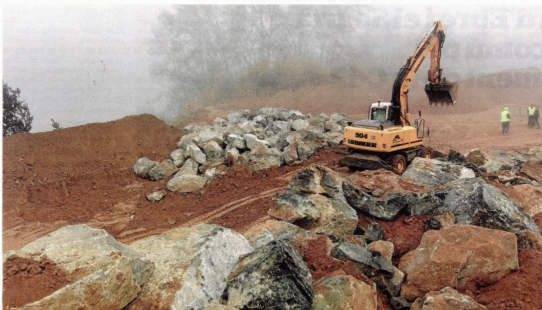
Obres en executió a tocar del riu Ebre, que no es veu a la imatge per la boira. FOTO: JOAN REVILLAS
