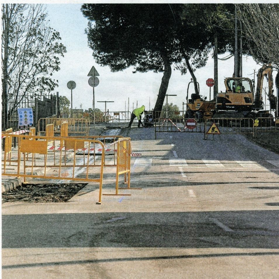
A causa de les obres el trànsit està restringit a la intersecció amb el carrer Bisbe Aznar. FOTO: J. REVILLAS
