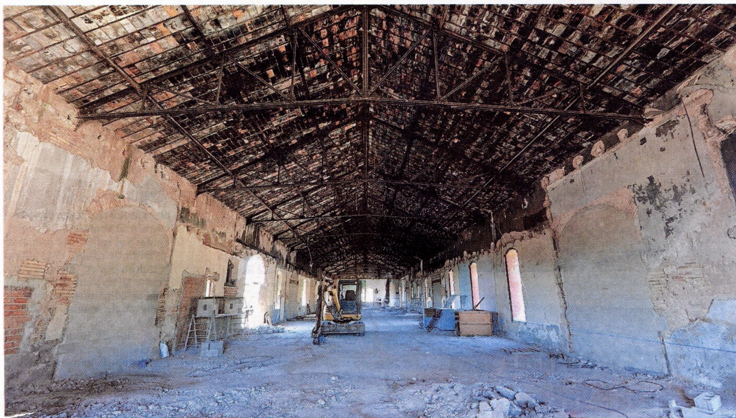
Obres en marxa a l'interior de l'antic moll de mercaderies de l'estació de Móra la Nova. FOTO: JOAN REVILLAS
