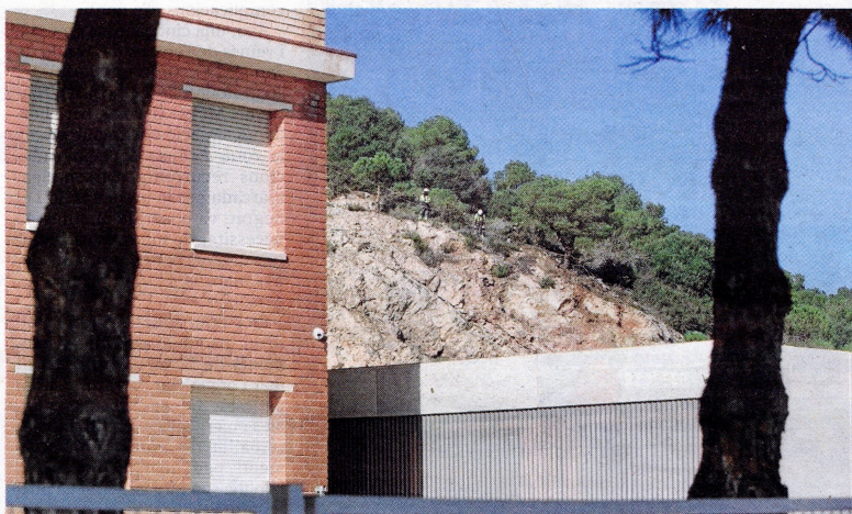
Operaris col·locant la malla metàl·lica a la pedrera, amb l'institut en primer terme. FOTO: JOAN REVILLAS
