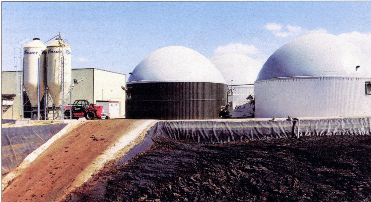
Els digestors de la planta de biometà de la Galera, al costat de la bassa amb residus orgànics valoritzables.
