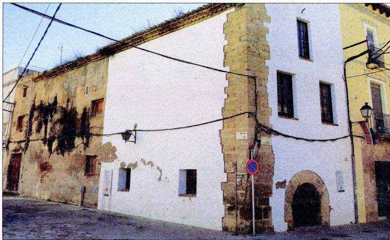
Estat actual de l'edifici conegut com la sinagoga, al call jueu de Tortosa. / CEDIDA
