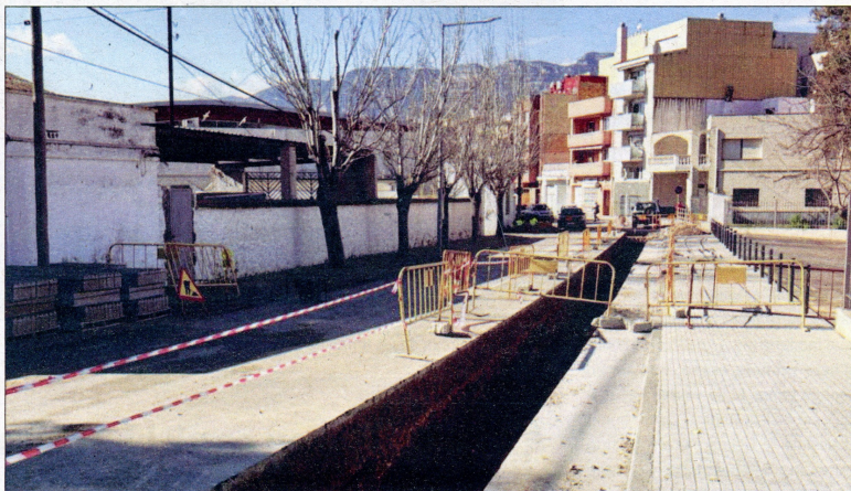
Una rasa oberta en un vial per a canalitzar serveis en el marc de les obres del projecte Ròtula Delta.
