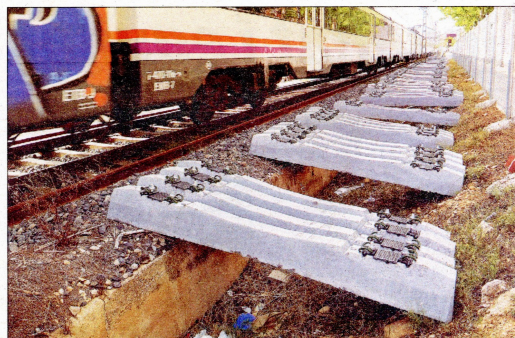
Travesses preparades per a canviar l'ample de via.
