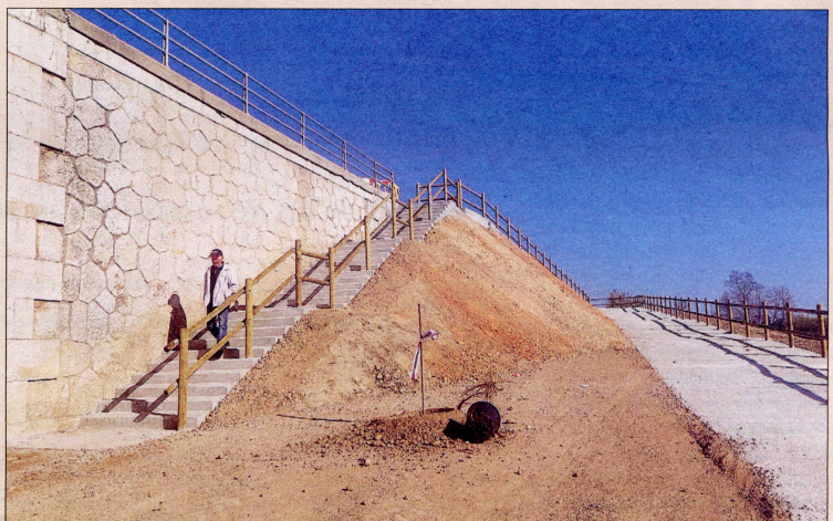
Estat actual de les obres de connexió de la Via Verda del Carrilet amb el Pont Penjant d'Amposta amb la nova rampa d'accés. / CARMÉ ROCA
