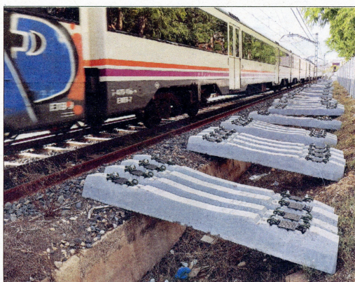
Travesses d'ample europeu preparades al tram entre Tortosa i l'Aldea.
