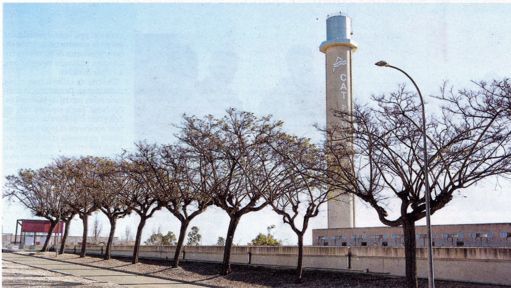
La planta de tractament de l'aigua al terme de l'Ampolla. FOTO: JOAN REVILLAS
