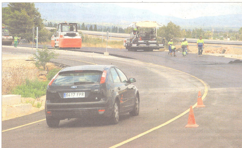
Un dels accessos a l'enllaç sud de la variant, ahir, amb els operaris treballant. FOTO: A. CARALT
