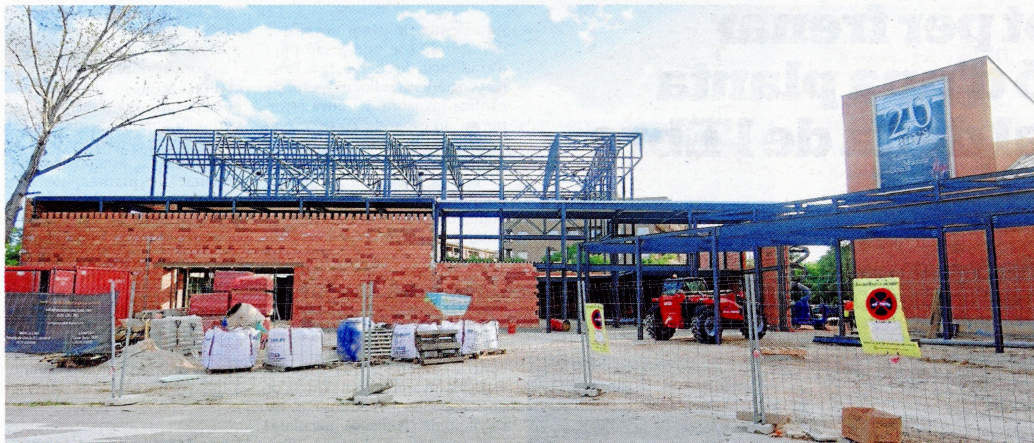
L'ampliació i millora del Teatre-Auditori Felip Pedrell continua aquest any. FOTO: JOAN REVILLAS
