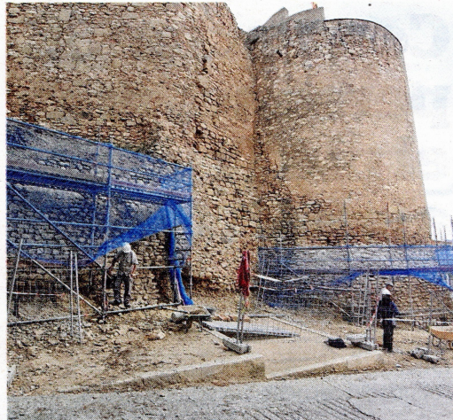
Actuació a la muralla del castell de Móra d'Ebre. FOTO: JOAN REVILLAS
