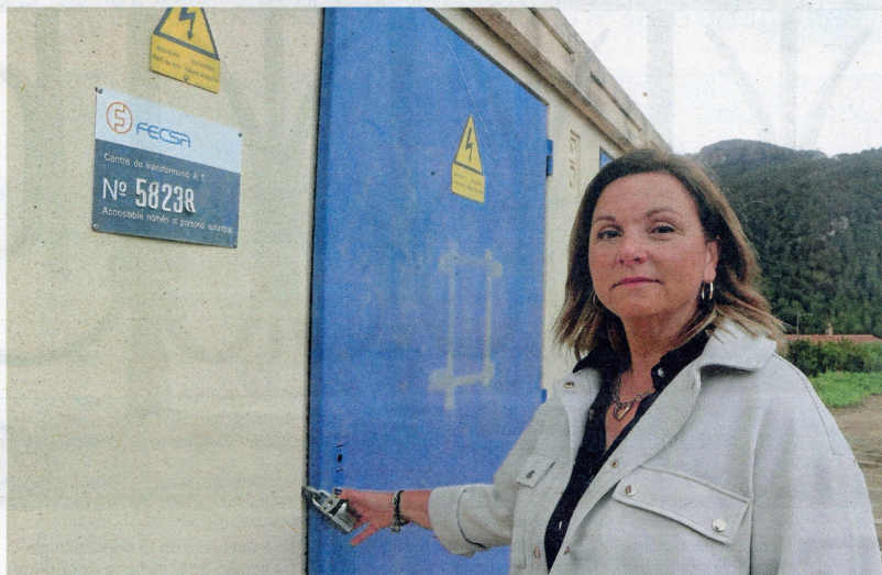
Silvia Carrillo, alcaldesa de Pratdip, ante la subestación de Endesa del núcleo urbano. FOTO: JORDI MARSL
