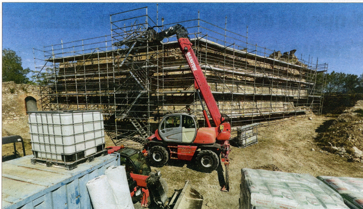
L'empresa constructora ha instal·lat bastides als panys de muralla amb l'objectiu d'executar la rehabilitació de la construcció militar. /JOAN JOSEP CAROT
