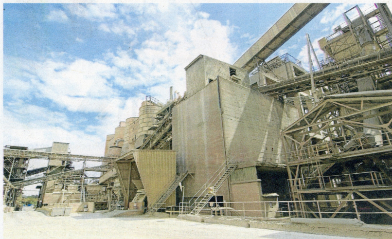
La planta de la multinacional cementera Cemex en Alcanar (Montsià). FOTO: JOAN REVILLAS
