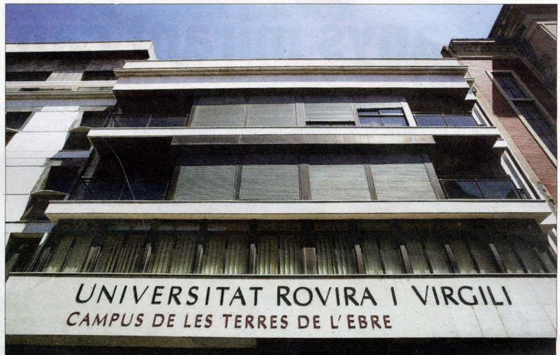
Façana de la primera seu del Campus Terres de l'Ebre de la URV, al carrer Teodor González de Tortosa. /ARXIU
