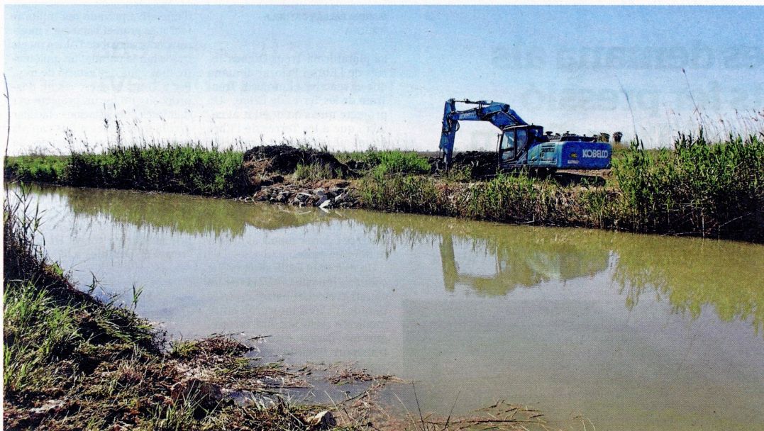
Treballs a la bassa de les Olles, al terme municipal de l'Ampolla. FOTO: JOAN REVILLAS
