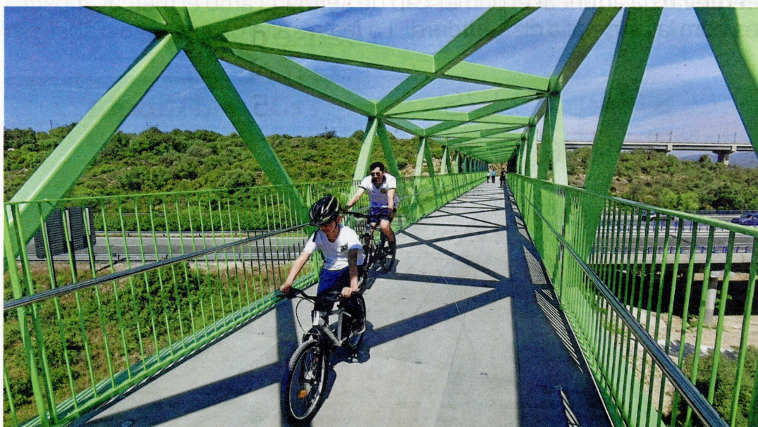
Ciclistes passant per la nova passarel·la de 90 metres construïda per travessar l'autopista i la C-12. FOTO: JOAN REVILLAS
