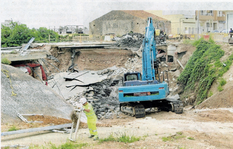
Màquines i operaris treballant en l'enderroc, ahir. FOTO: JOAN REVILLAS
