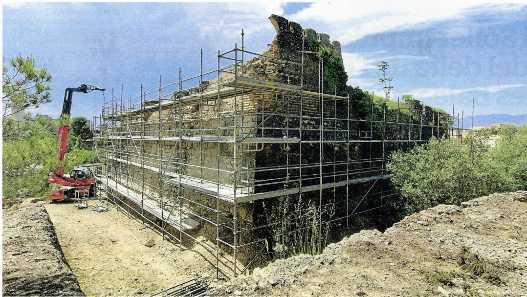
La gran bastida instal·lada en el marc dels treballs de recuperació del fortí de Bonet. FOTO: JOAN REVILLAS
