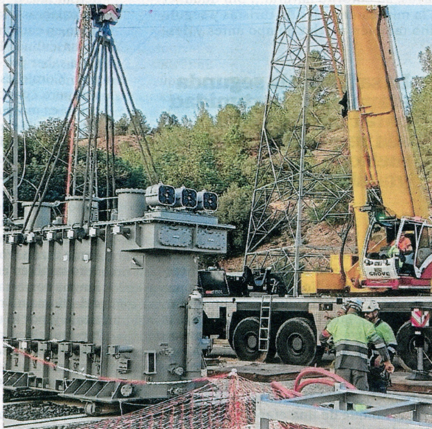
Instal·lació del nou transformador a la subestació. FOTO: ENDESA
