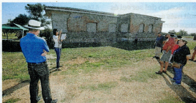
L'antic Camp d'Aviació construït durant la Guerra Civil al terme de la Sénia. FOTO: JOAN REVILLAS
