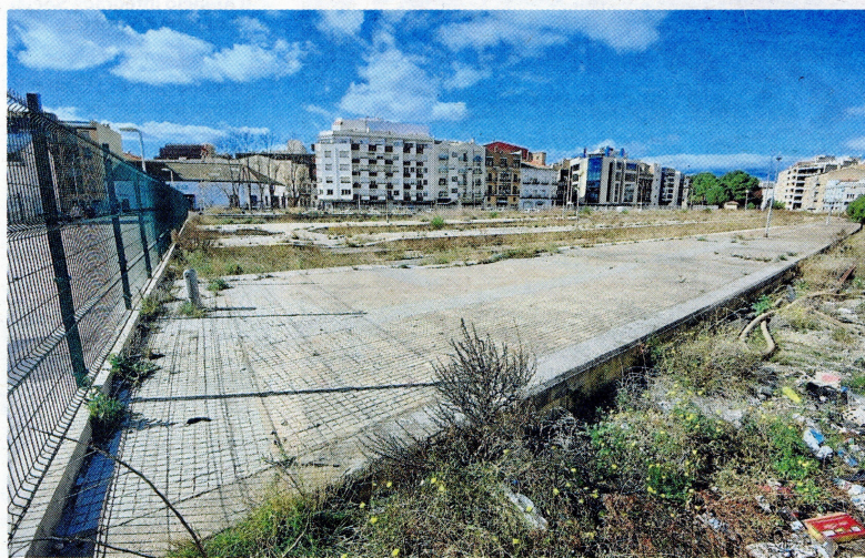
Els terrenys on s'ha de construir l'aparcament en superfície. FOTO: JOAN REVILLAS
