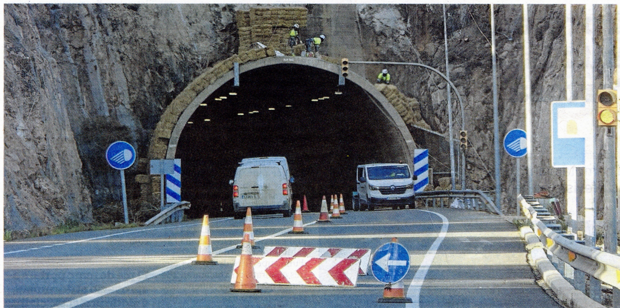
Obres de seguretat a la boca del túnel de Xalamera, a Benifallet. FOTO: JOAN REVILLAS
