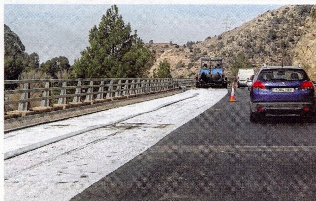
Millora del ferm de la carretera a l'altura del Pas de l'Ase, a la Ribera d'Ebre. FOTO: JOAN REVILLAS
