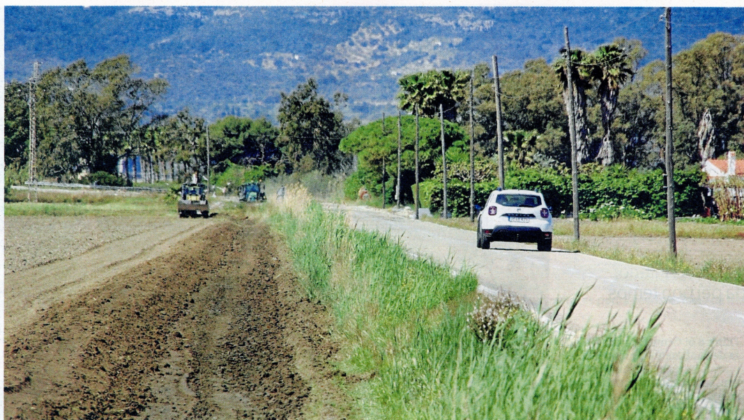
Treballs en execució als camps vora la carretera T-2021. FOTO: JOAN REVILLAS
