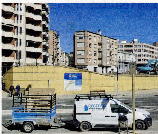
El talús que d'aquí pocs dies deixarà d'existir i que també canviarà la imatge de l'avinguda de la Generalitat. FOTO: J. REVILLAS
