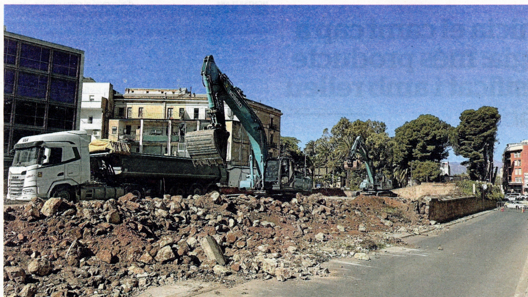
Màquines excavadores treballant per aplanar l'espai on anirà el nou aparcament, ahir a la tarda, a Ronda Reus. FOTO: J. REVILLAS
