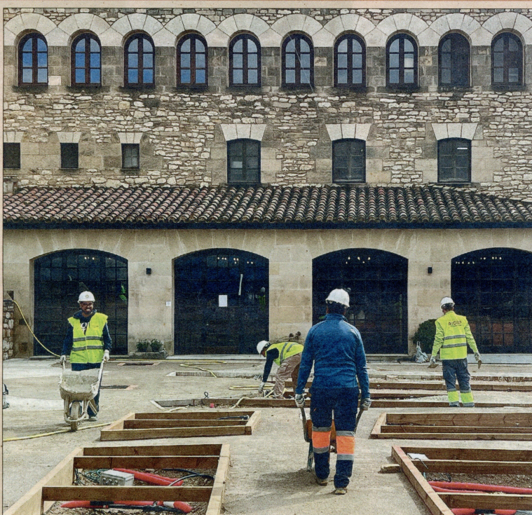
Estat dels reballs dilluns passat al voltant del pou central d'època àrab del castell. / JOAN JOSEP CAROT
