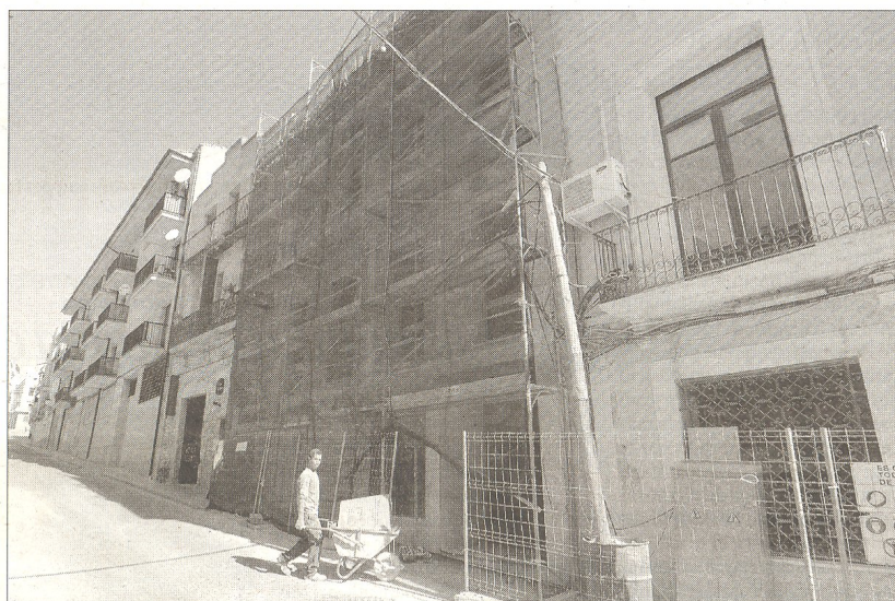
El nou centre cívic, l'única obra en marxa. - La construcció del centre cívic és actualment l'única obra en marxa de la Llei de Barris. Tot i que estava previst finalitzar les obres aquest estiu, la construcció no és culminarà fins al desembre. El centre cívic comptarà amb una sala polivalent per oferir xerrades. Les obres han permès també arranjat la teulada de l'ajuntament, ubicat al costat, una obra no prevista en un inici. FOTO: J.R.
