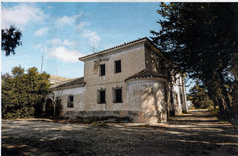
L'antiga caserna de la Guàrdia Civil que s'enderrocarà. FOTO: JOAN REVILLAS
