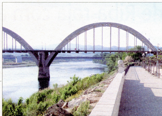
El pont de les arcades que uneix les dues Mòres, un conjunt que s'apropa als deu mil veïns, gairebé la meitat de la comarca, que s'incrementarà amb el nou projecte.
