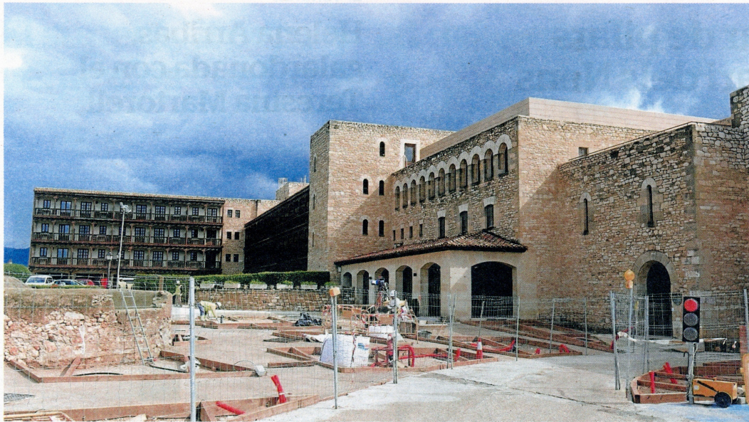
La zona exterior del Parador de Tortosa, en obres. FOTO: JOAN REVILLAS
