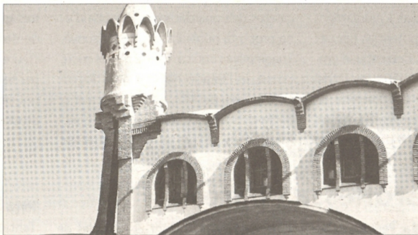
El celler cooperatiu de Gandesa s'està rehabilitant.
