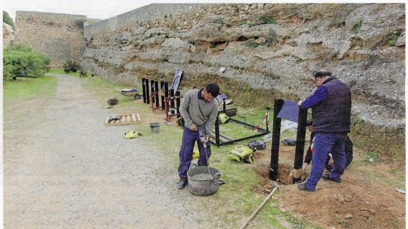
Treballs per instal·lar els plafons, aquest dimecres. FOTO: J. REVILLAS
