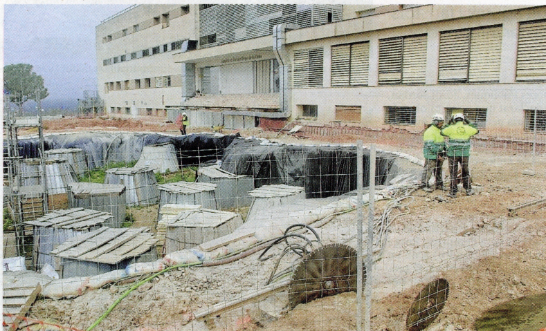
Treballs en execució a l'Hospital de Tortosa Verge de la Cinta. FOTO: JOAN REVILLAS
