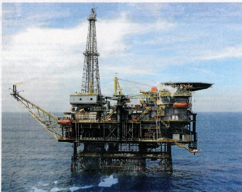
La plataforma petrolífera Casablanca, ubicada a unos 40 kilómetros del Delta. FOTO: JORDI MARSAL/ACN
