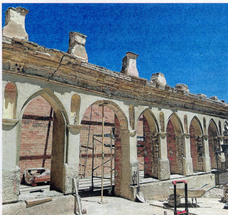
Els treballs a la galeria d'arcs apuntats, que presentava un estat molt degradat. FOTO: AJUNTAMENT DE TORTOSA
